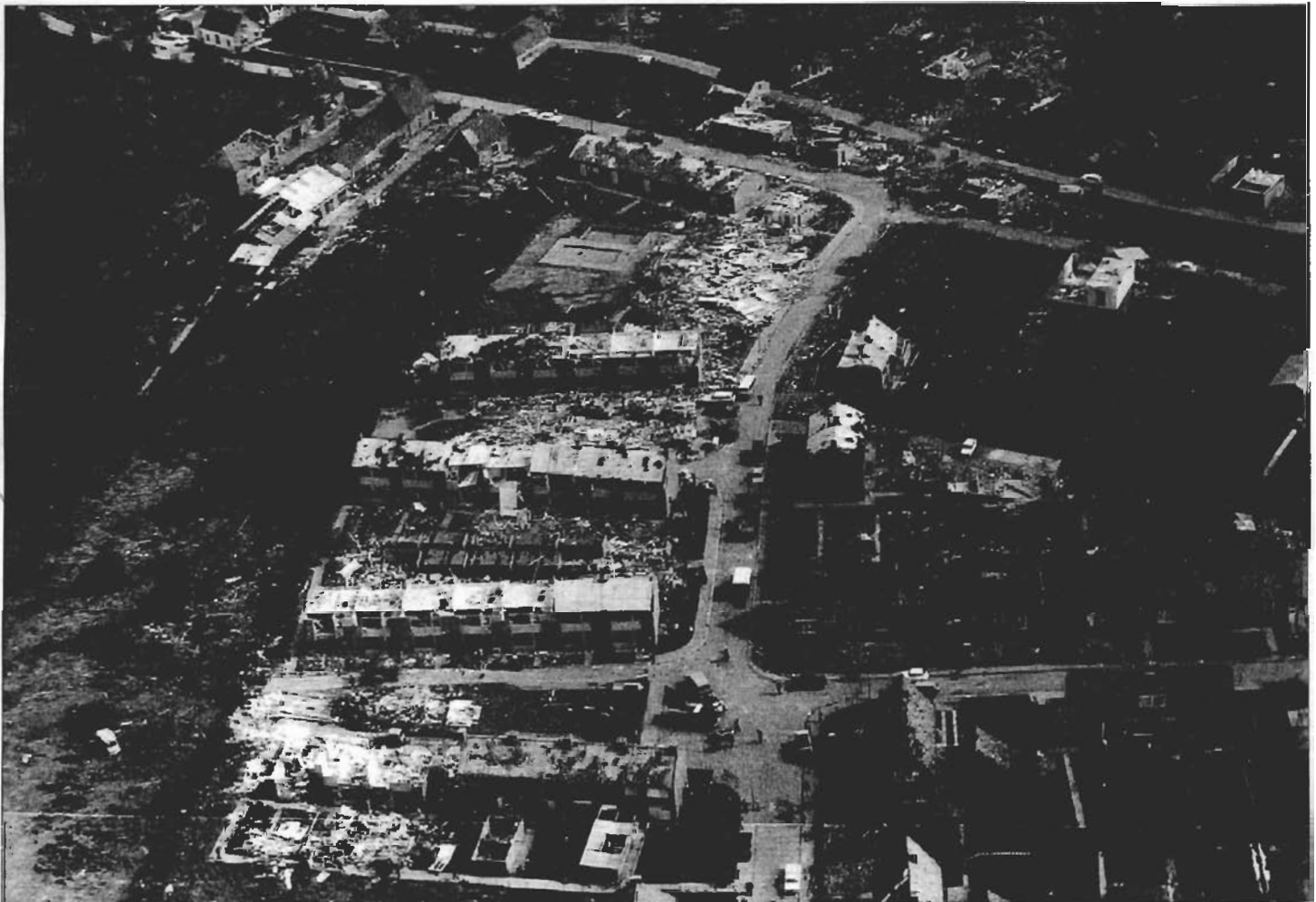
Schadespoor in een nieuwbouwwijk, veroorzaakt door de hoos van Tricht op 25 juni 1967. (foto Koninklijke Luchtmacht)
